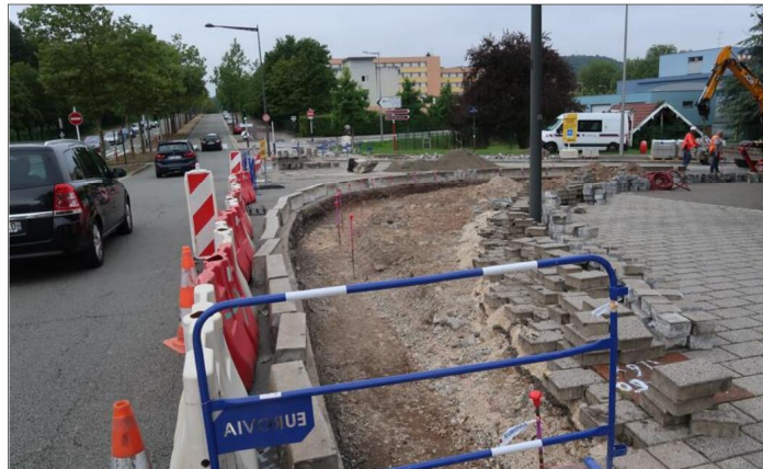
Les travaux doivent se terminer pour la rentrée de septembre. Photo ER/Pascal CHEVILLOT
