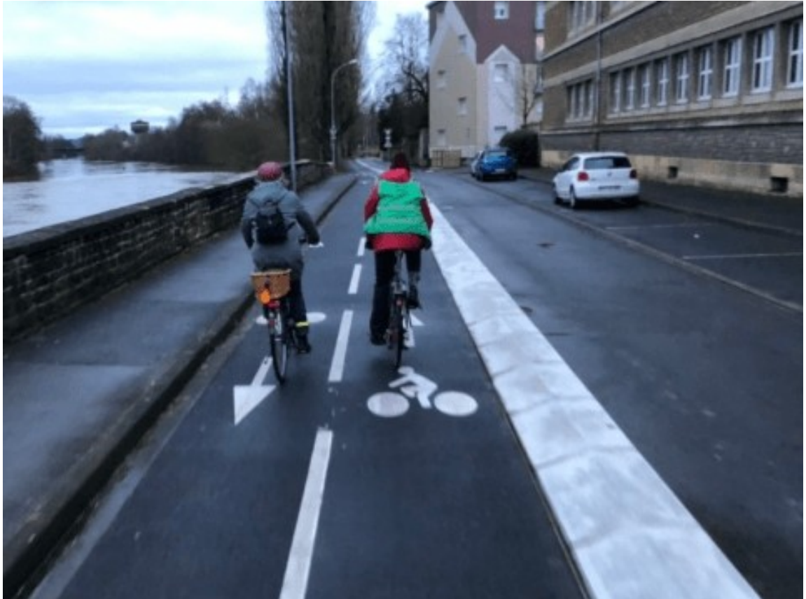
Exemple de bordure entre piste et voie voiture
