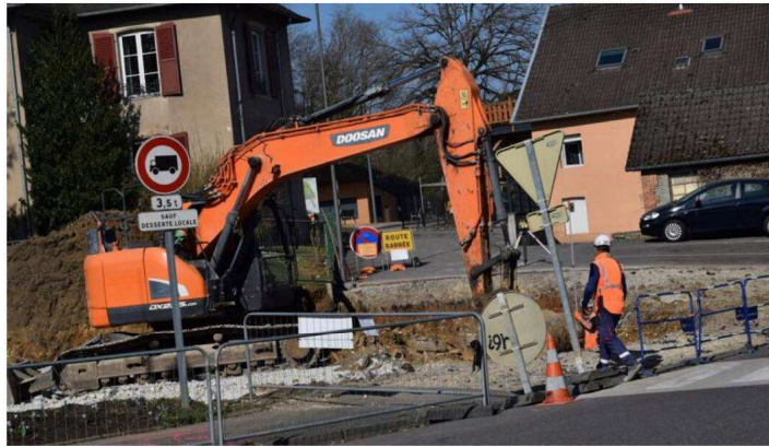
Les travaux ont débuté au croisement de la Grande rue François-Mitterrand et de la rue de la Libération. Un rond-point censé faciliter le trafic doit voir le jour dans quelques mois.
