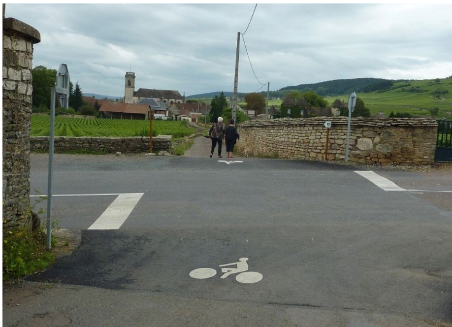
Véloroute prioritaire sur voie secondaire Source : Cerema
